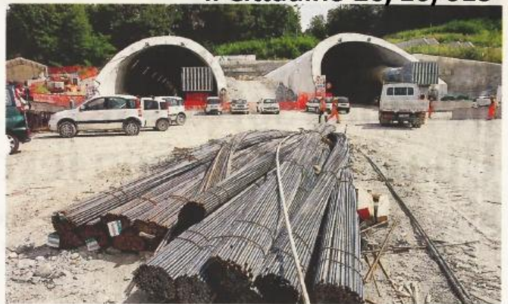
Il cantiere attuale di Pedemontana, nella zona di Varese
