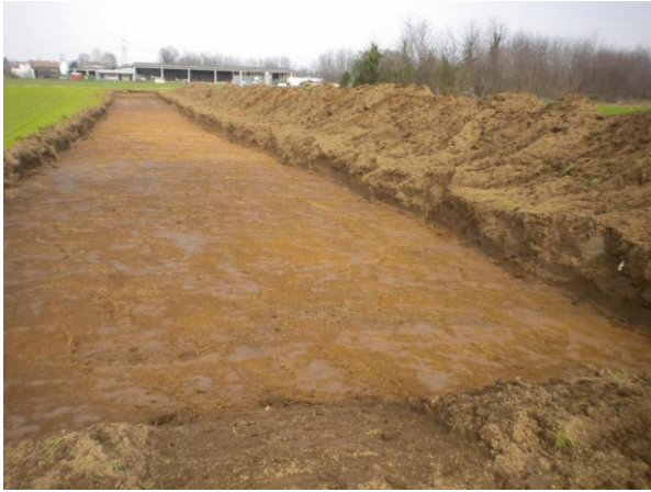
Scavi di superficie a Copreno
