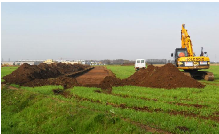
I lavori di tracciatura proseguono
